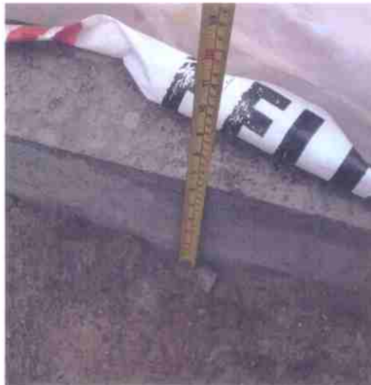
Fotografía N° 12, terminación superficial de subbase pasaje Los Espinos, 29 de octubre de 2015.
