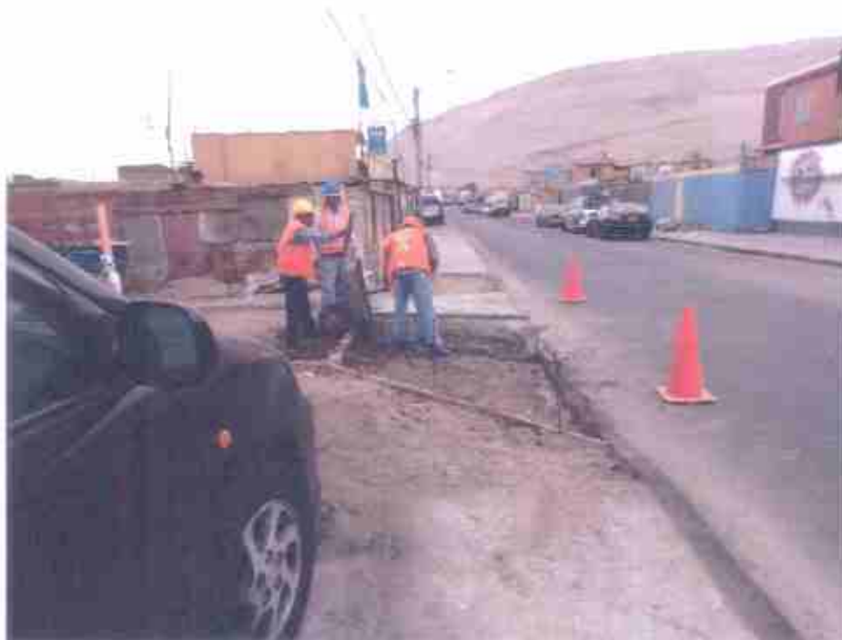
Fotografía N° 10, colocación del hormigón sin compactar, 26 de octubre de 2015.
