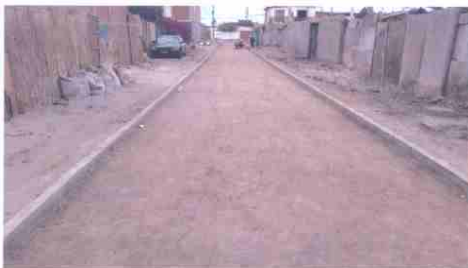
Fotografía N° 4, subbase granular adocretos, pasaje Los Espinos (Barros Luco – Los Avellanos), 26 de octubre de 2015.
