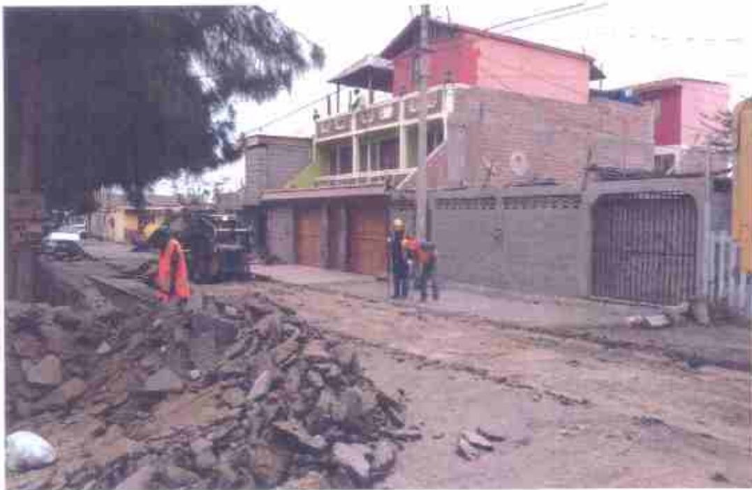
Fotografía N° 14, faenas de demolición y extracción obras existentes, 29 de octubre de 2015.
