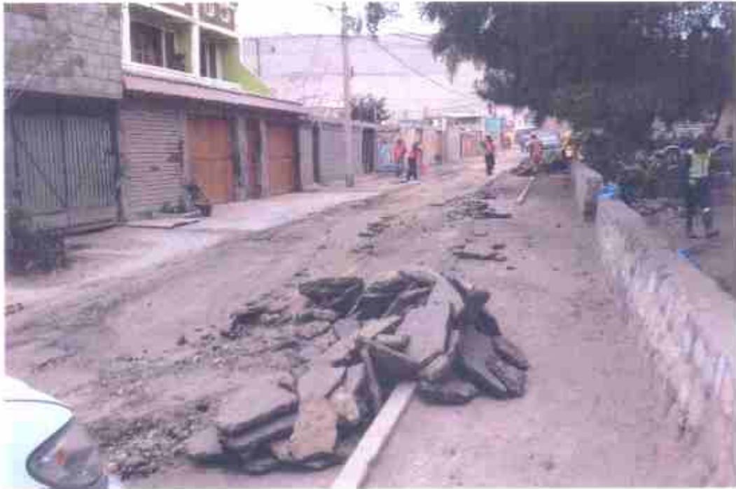
Fotografía N° 13, faenas de demolición y extracción obras existentes, 29 de octubre de 2015.
