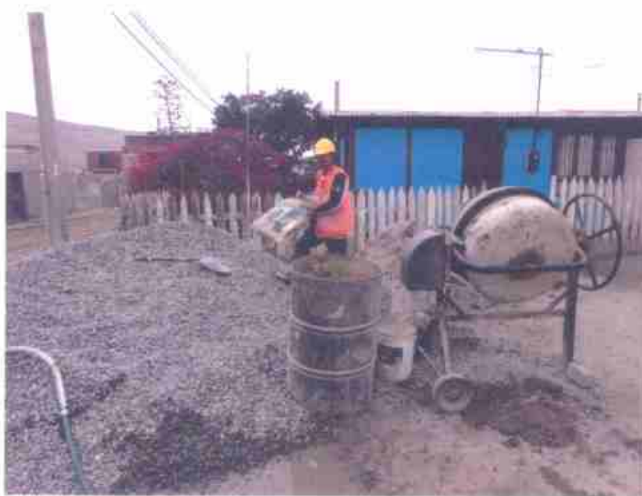
Fotografía N° 8, confección de hormigón en obra, 26 de octubre de 2015.
