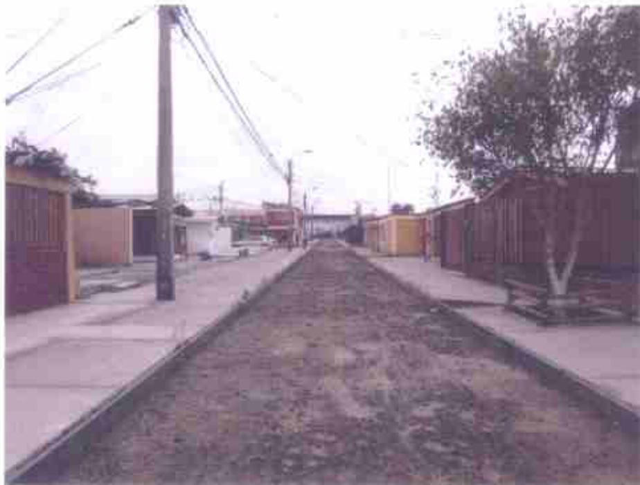
Fotografía N° 7, base granular recibida, pasaje Venezuela (Sta. María – fin del pasaje), 26 de octubre de 2015.
